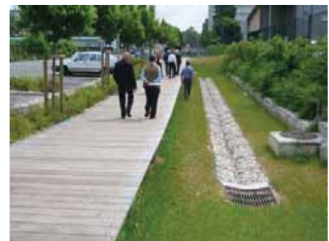
Noue de stockage à Clichy-sous-Bois
