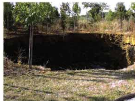
Affaissement dans un parc public (Seine-Saint-Denis)
