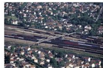
Voies ferrées SNCF
