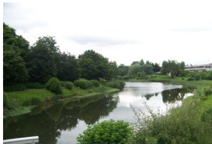
Le bassin du Pont-Yblon
