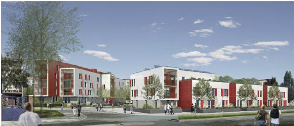
Perspective sur les bâtiments D1 et E2 dans le secteur PRU Sud
